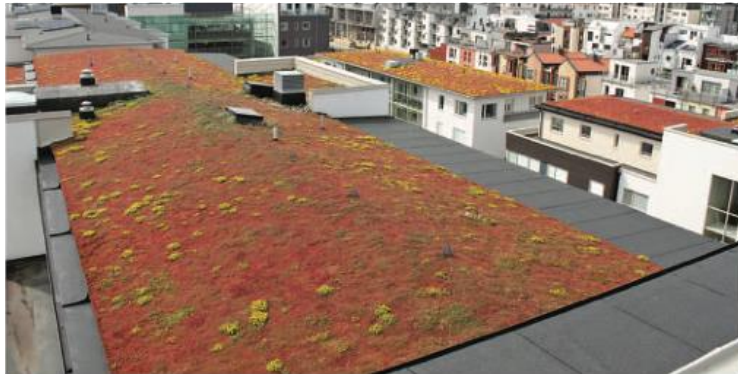
Kuva 1. Maksaruohoa käytetään yleisimmin suurten kerrostalojen viherkatossa. Katosta saadaan värikäs käyttämällä eri maksaruoholajeja.
